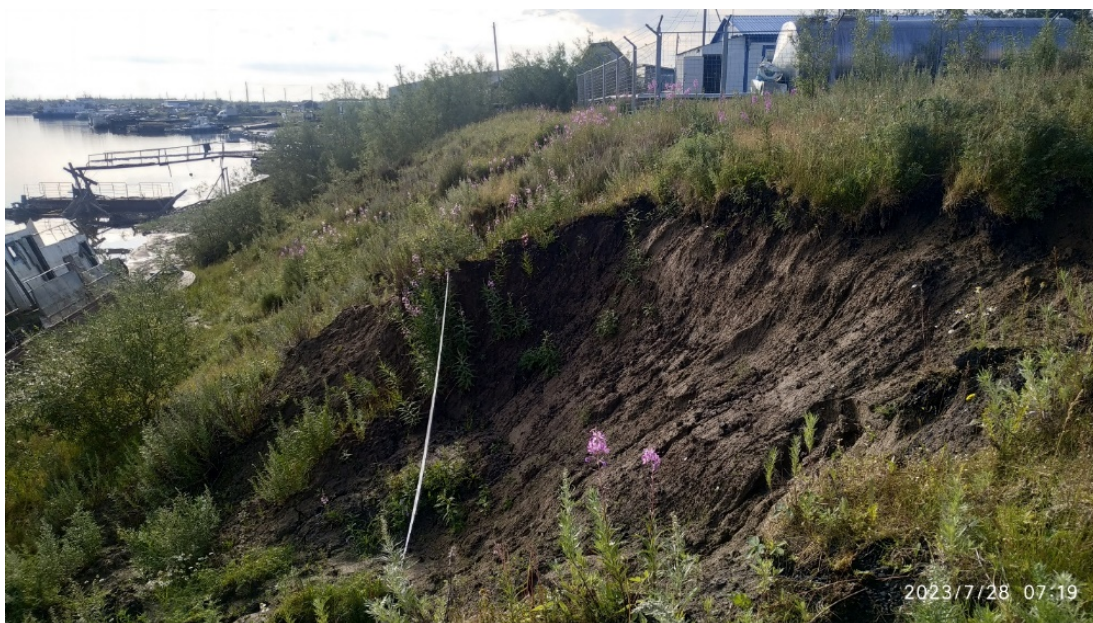
Фото 89-11-00242. Развитие оползневой процесса на правом берегу р. Щучья, в створе административного здания совхоза Байдарацкий. ЯНАО
