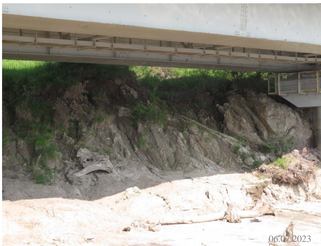
Фото 86-1210-0516-1. г. Ханты-Мансийск, ул. Восточная объездная, мост Оползневой участок «пьяный лес», язык оползня упирается в опоры моста. ХМАО-Югра
