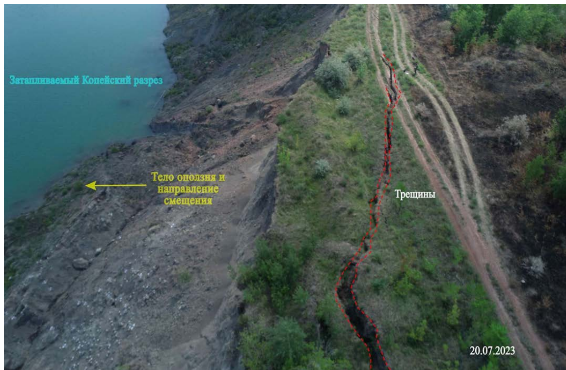
Фото 74-11-00067. Формирование нового блока отрыва в ТН 12 на борту Копейского разреза. Участок Копейский Челябинской области
