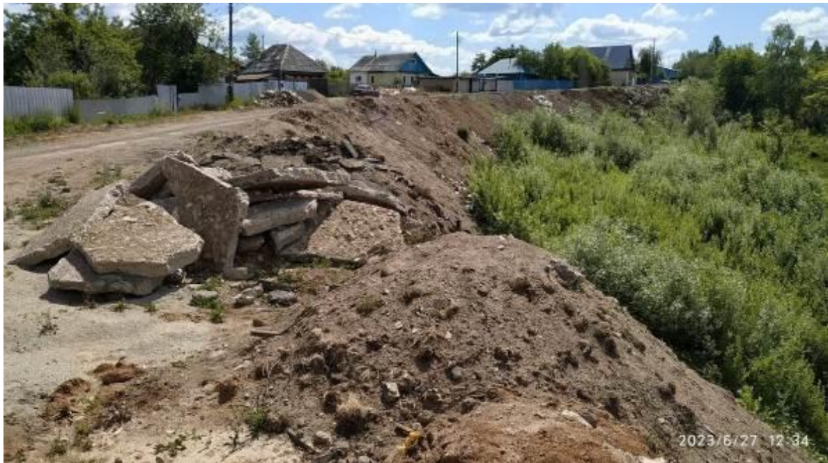
Фото 74-11-00052. Отсыпка для увеличения ширины проезжей части на оползневом участке по ул. Набережная, дома № 67-77 в г. Аша. Участок Ашинский, Челябинская область
