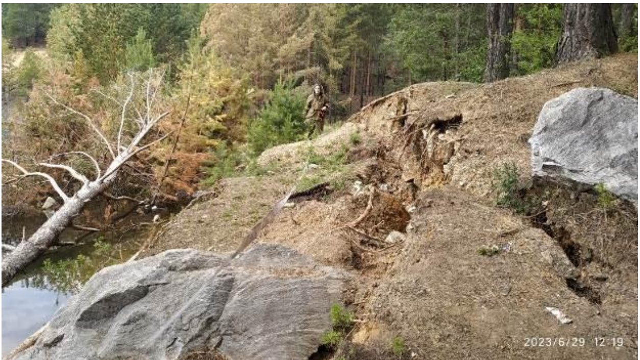
Фото 74-2023-01-001. Участок активизации оползневого процесса на борту Тюленевского карьера в г. Верхний Уфалей. Участок Верхнеуфалейский, Челябинская область
