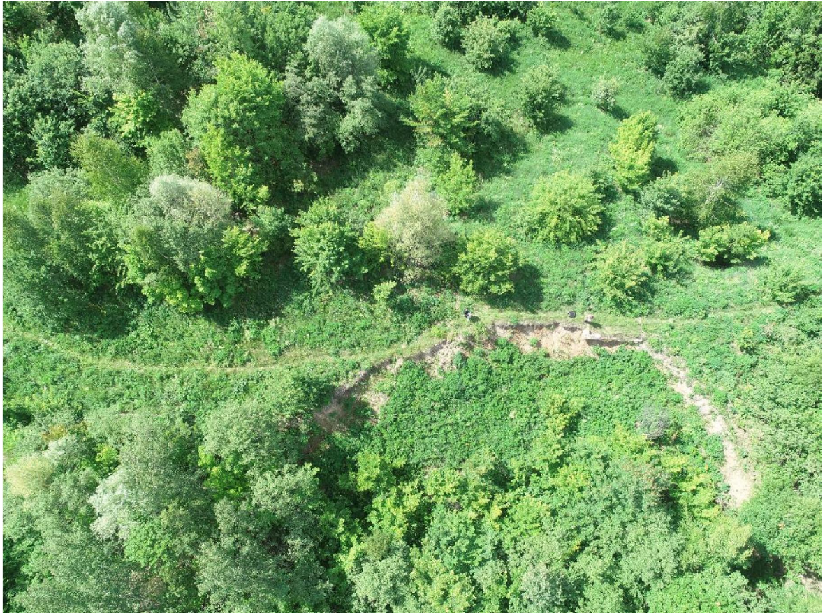
Фото 74-11-00049. Оползень в 140 м западнее кладбища г. Аша. Участок Ашинский, Челябинская область
