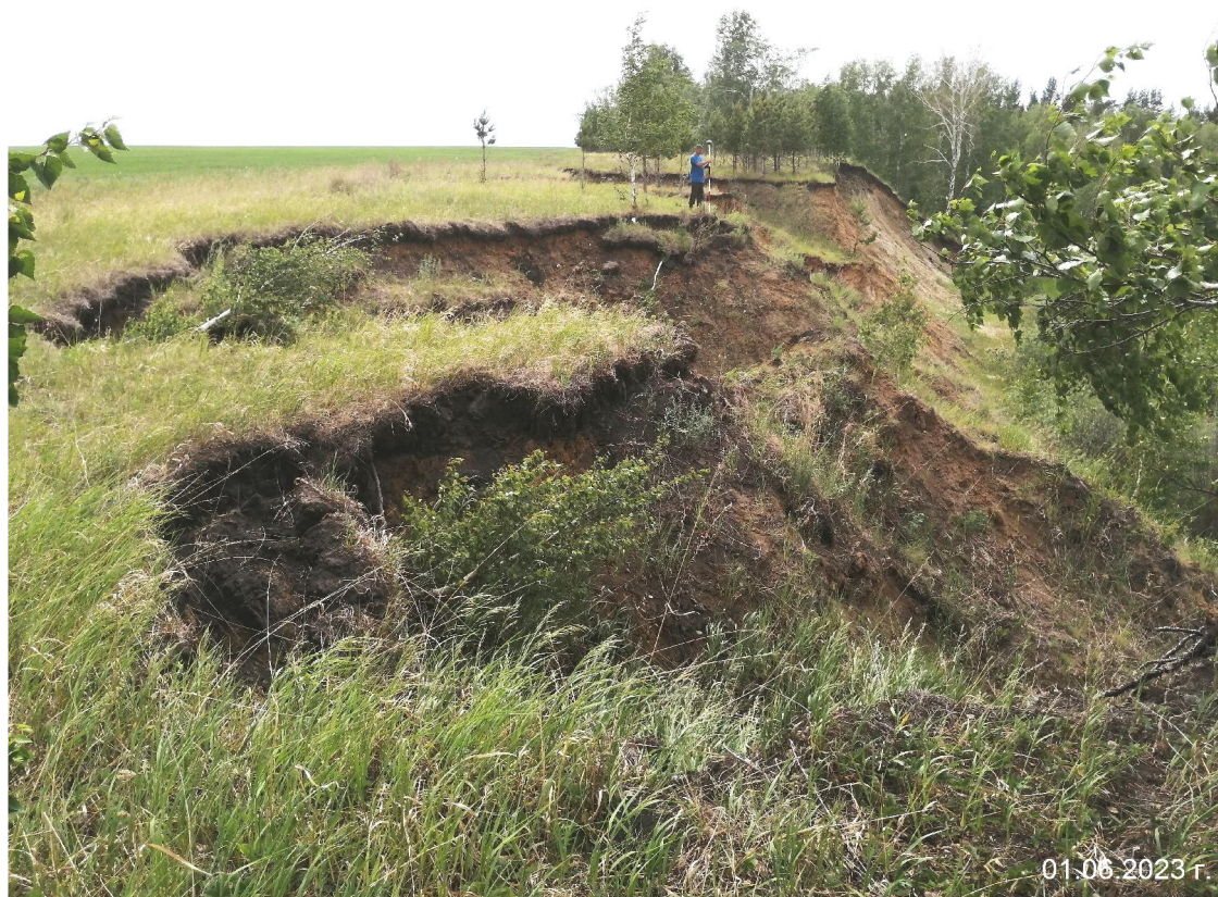
Фото 45-11-00035. Формирование эрозионных промоин на бровке оползневого цирка. Нечунаевский участок, Каргапольский район, Курганская область. Вид на юго-запад
