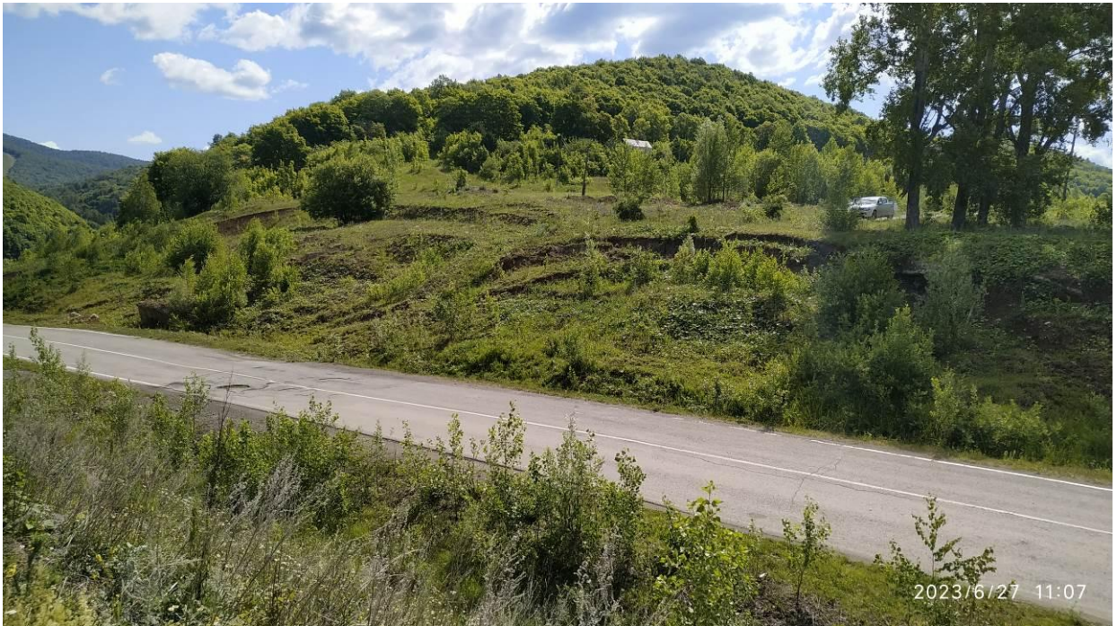
Фото 74-11-00048. Техногенный оползень по автодороге на горнолыжный комплекс Аджигардак. Участок Ашинский, г. Аша, Челябинская область
