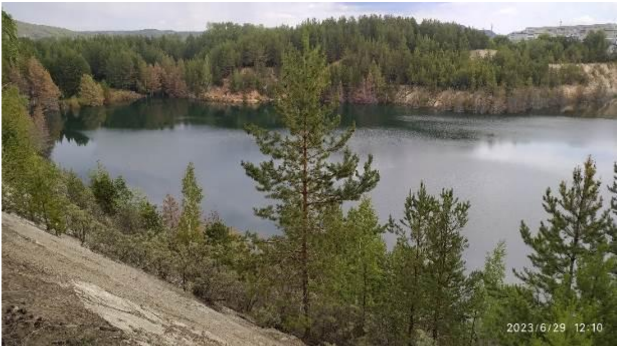
Фото 74-2023-01-001. Развитие комплекса гравитационных процессов (оползни, осыпи, обрушения) по бортам Тюленевского карьера в г. Верхний Уфалей. Участок Верхнеуфалейский, Челябинская область
