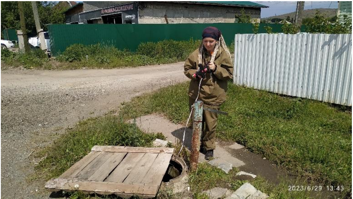
Фото 74-2023-01-001. Замер уровня грунтовых вод на локальных участках развития процесса подтопления в г. Верхний Уфалей. Участок Верхнеуфалейский, Челябинская область
